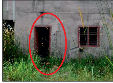
PAKR Wang Kelian - Pintu Rosak Akibat Serangan Anai-Anai (17.11.2020) (Sumber: Jabatan Audit Negara Negeri Perlis)
